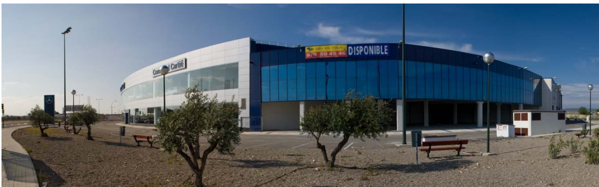
C/ Tarento (Zaragoza) Edificio Prefabricado Multipropiedad
